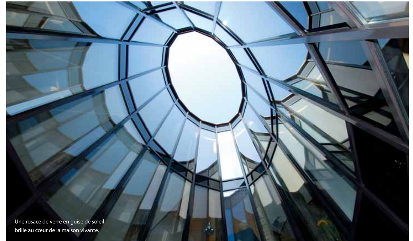
Le puits de lumière constitué selon le système CW 50 de Reynaers Aluminium canalise la lumière zénithale dans la clairière intérieure.
