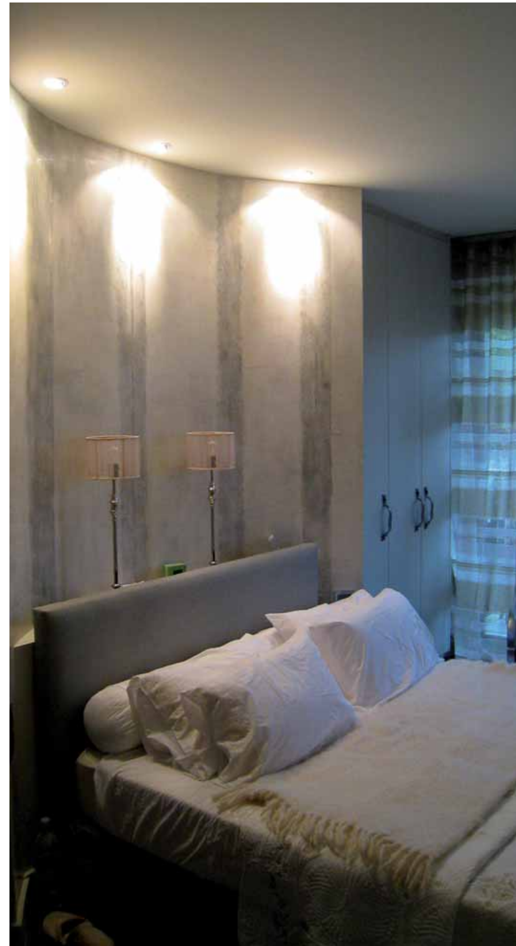
L'une des quatre chambres de l'appartement. Ici, le faux-plafond est en staff (mélange de plâtre à mouler et de fibres végétales) alors qu'en tête de lit, l'effet matière a été obtenu en collant des bandes de dentelle sur un enduit puis en les arrachant !
