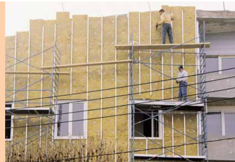
Le bardage isolant extérieur est une excellente solution en termes de performance thermiques. (Rockwool)
