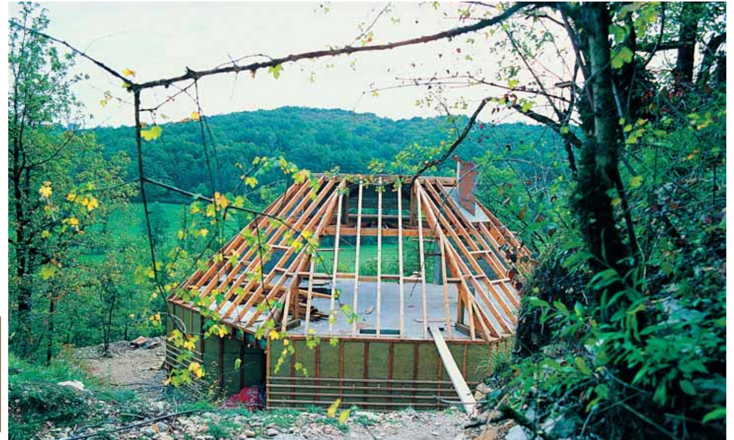
Cette maison à ossature bois sera isolée avec de la laine de roche. (Rockwool)
