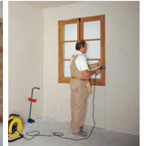
Doublage thermo-acoustique sur montants. (Placo)
