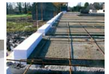
Pose des isorupteurs HB60 de KP1, en polystyrène (KP1)
