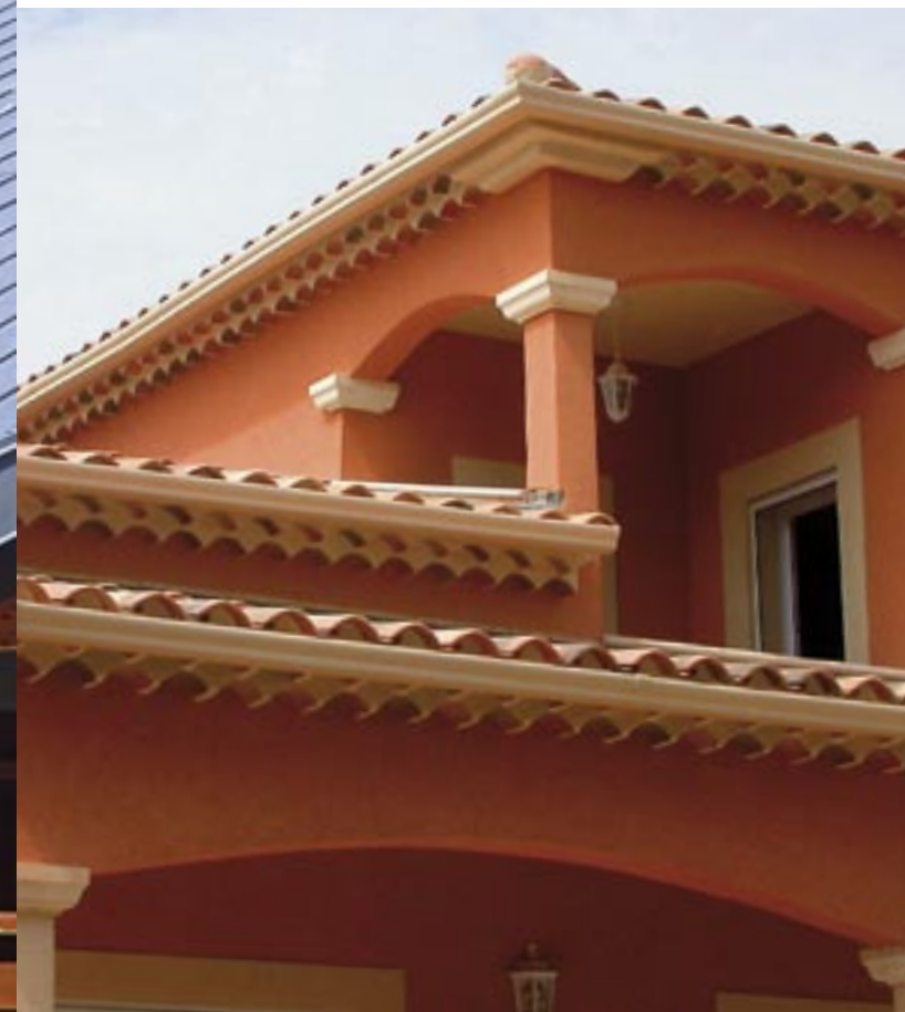
(Nicoll) L'intégration des gouttières au bâti est devenue une question majeure à satisfaire.
