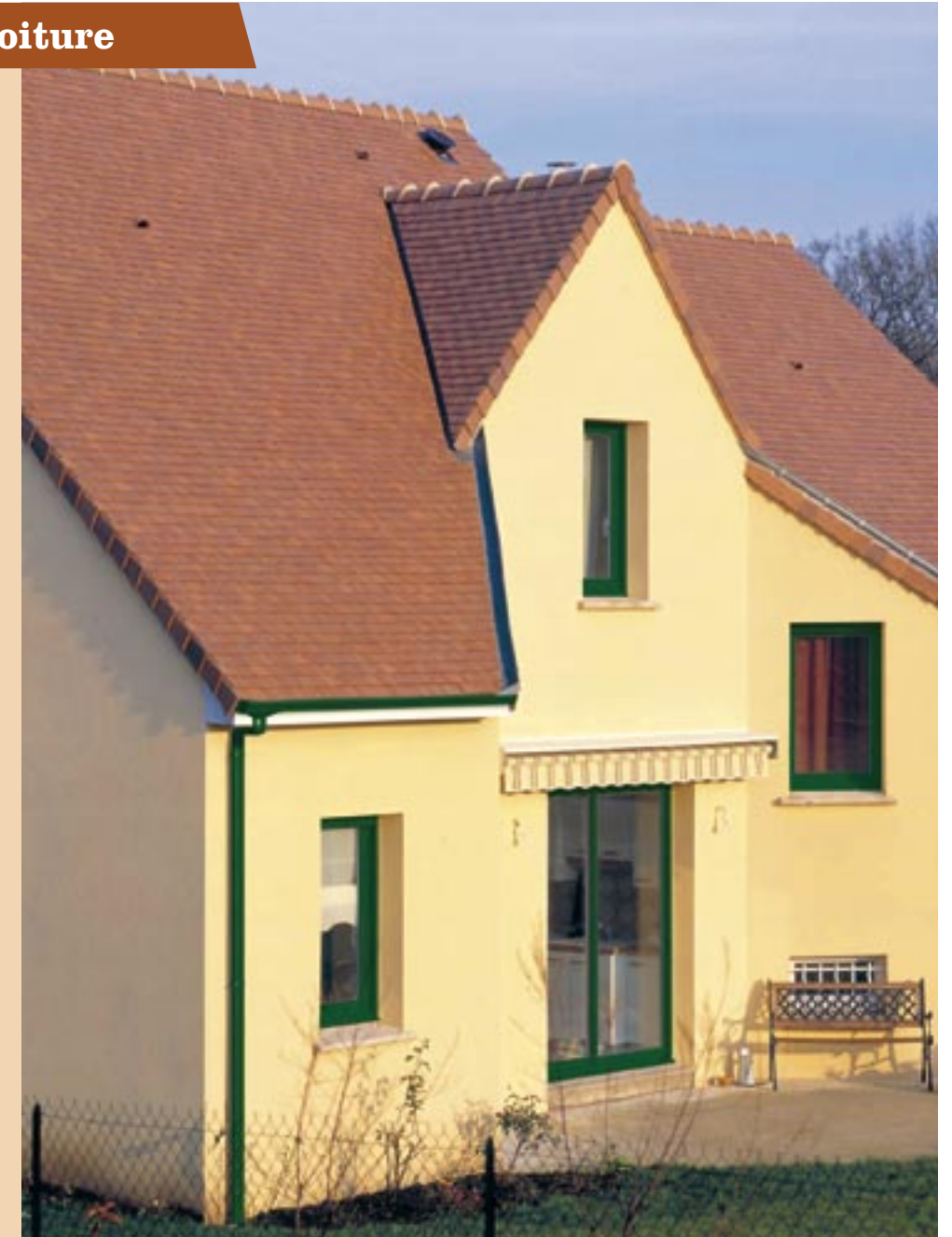
(Nicoll) L'intégration des gouttières au bâti est devenue une question majeure à satisfaire.
