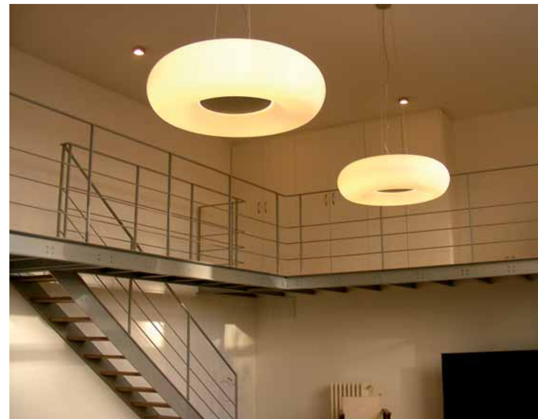
Les poutres de la passerelle, créées sur mesure, ont été peintes au four dans un gris atelier, avant d'être posées.
