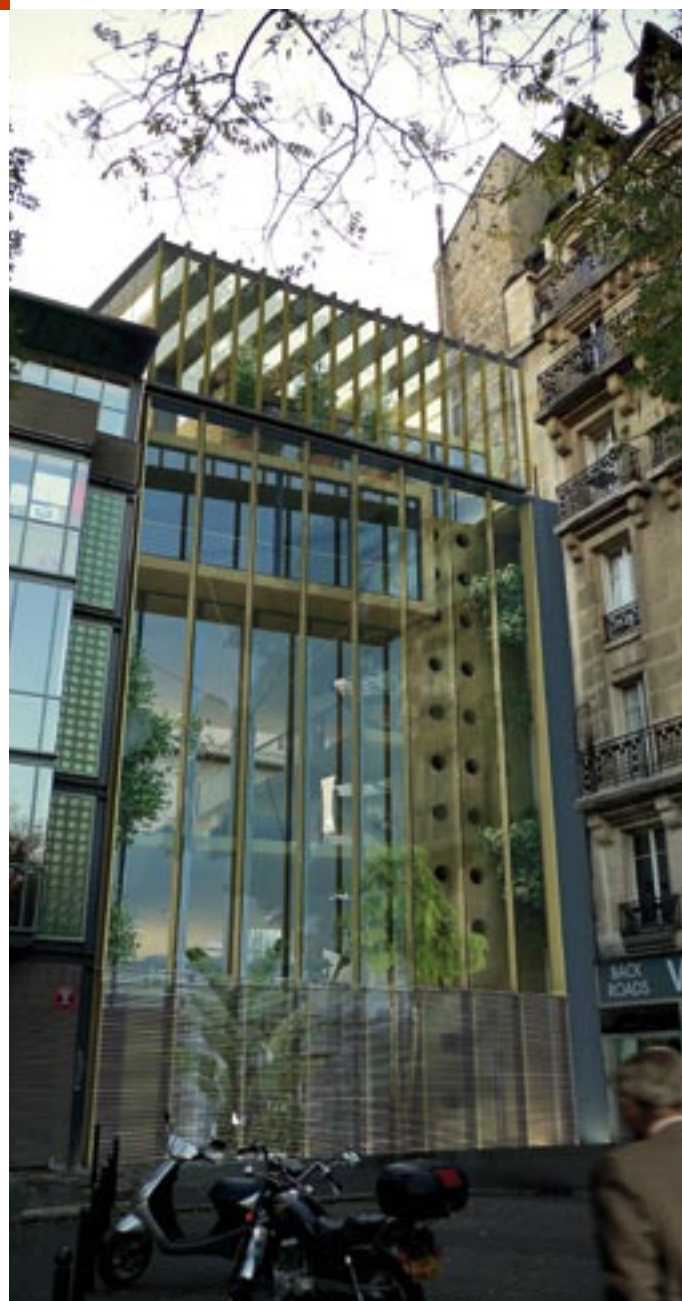
Serre climatique, structure bois, captage solaire et géothermique, régulation thermique : les derniers procédés innovants en matière énergétique ont été utilisés.
