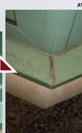
Les jointures constituent des points faibles où une porosité peut apparaître entre l'aluminium et la laque qui le protège. (MG color paint)
