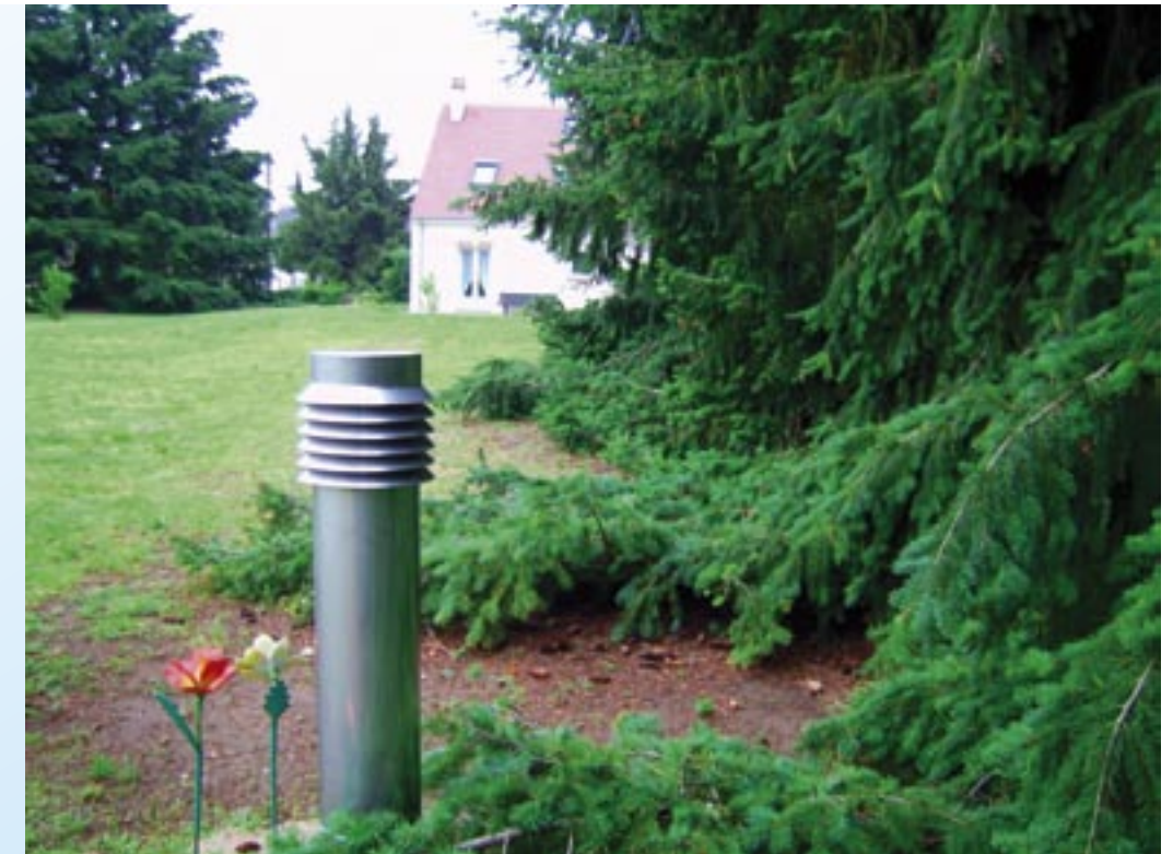
L'entrée d'air du puits canadien est relativement discrète et peut se dissimuler dans le paysage du jardin. (Fiabibat Concept)
