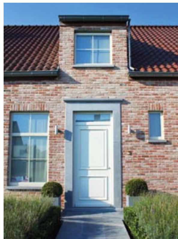
Logé au-dessus de la fenêtre, l'appareil Isivent assure une ventilation de base efficace (Renson).
