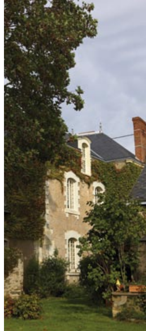
La corniche a été refaite en pierres de tuffeau.
