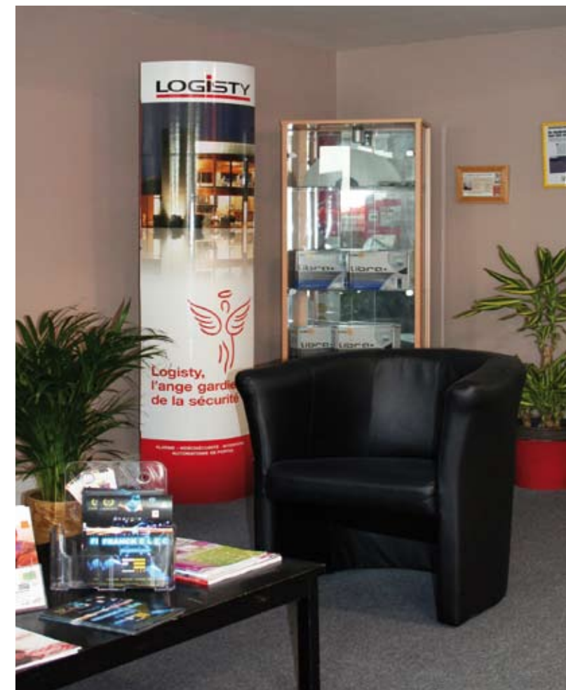
Les locaux de Franckelec, avec au rez-de-chaussée un tableau électrique de domotique.
