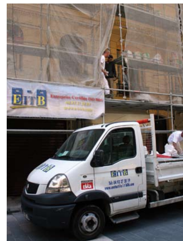
EITB peut installer jusqu'à 8 000 m 2 d'échafaudage fixe, avec platelage.
